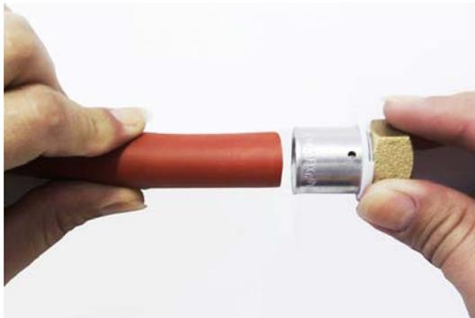
2. Introduire le tube au fond de l'ensemble raccord-bague.
